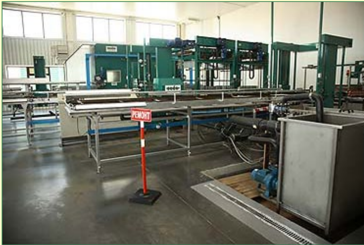
Von der Halle mit Wasserentleerung...
