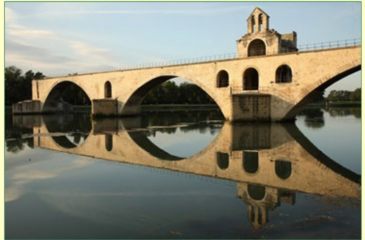
„Sous le pont d'Avignon“
