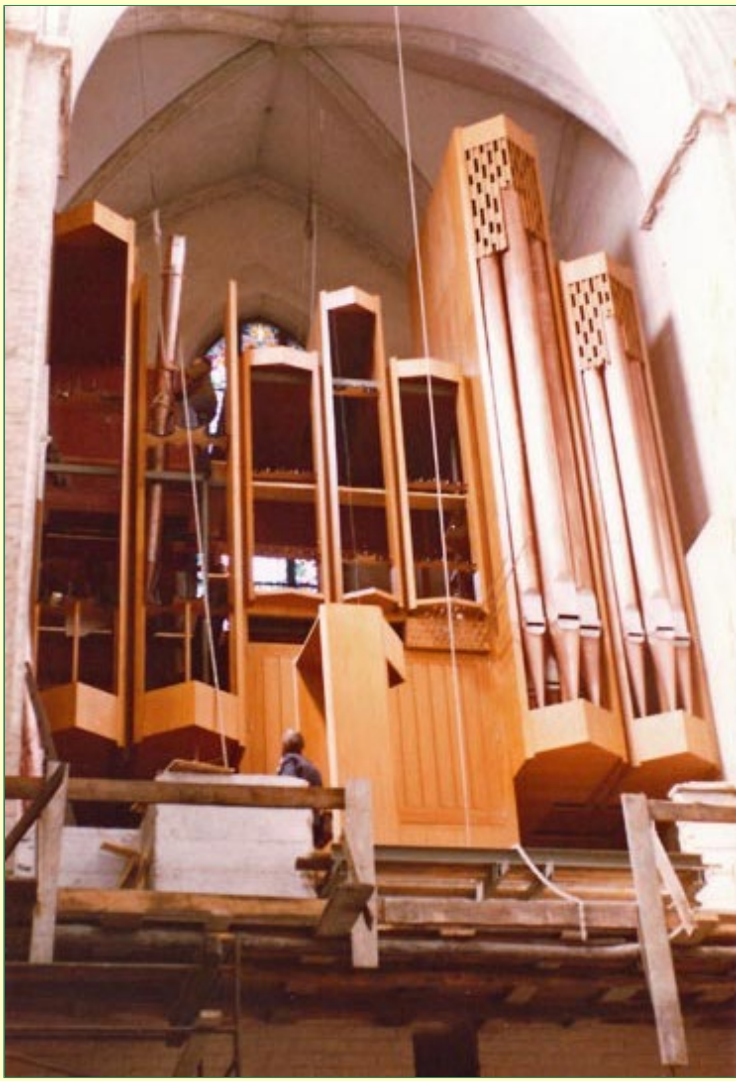
Einbau einer neuen Orgel durch die Bonner Firma Klais
